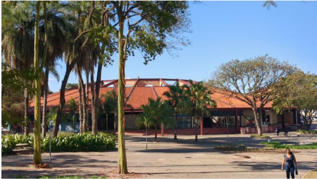
Theatrum Mundi : praça do serviços at Universidade Federal de Minas Gerais in Belo Horizonte
